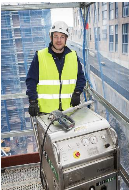
Tommy Magnusson vid en av de tre blästringmaskinerna som används vid saneringen av Qvarnen Tre Kronor.
